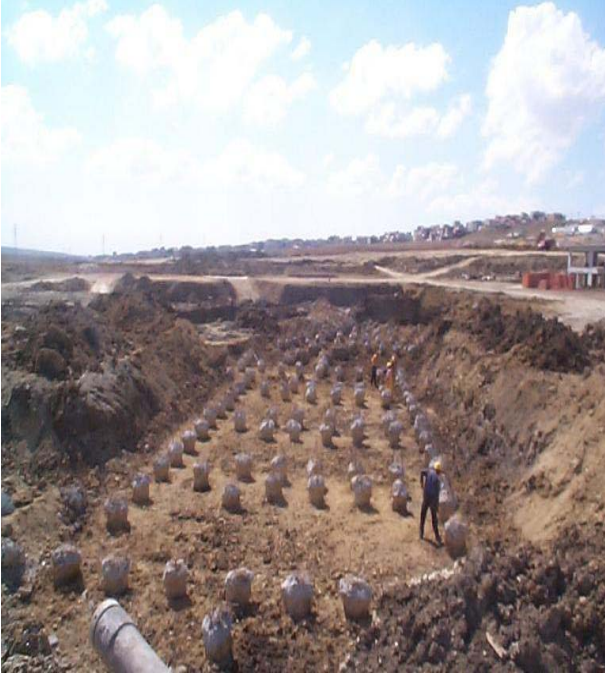
Şekil 9. Konutların altlarında imal edilmiş yerinde dökme kazıklar
