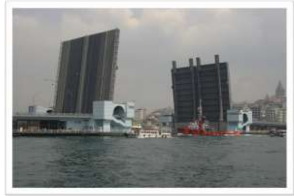
Şekil 16. Baskül köprü kanatları, açık halleri
