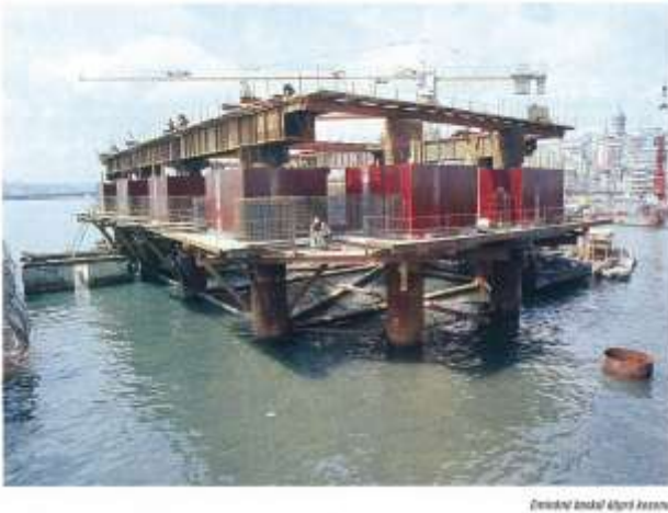
Şekil 12. Eminönü baskül köprü kesonu
