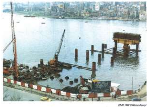
Şekil 9. 29.02.1988 Kazık yükleme deneyi
