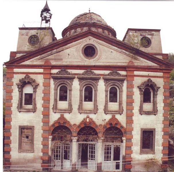
Şekil 18. Talas Panagia Kilisesi (Ş. Güngör Açıkgöz)
