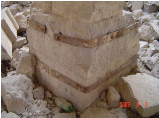
Şekil 20. Yanartaş Manastır Kilisesi'nde onarım kuşakları (Ş. Güngör Açıkgöz)
