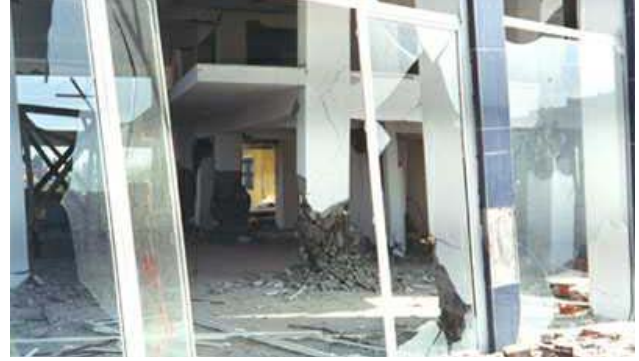
Şekil 18. Alan kazanmak amacıyla strüktürü bozulan bir yapının 17 Ağustos depreminde uğradığı hasar ( www.avnidincer.8m.com )
