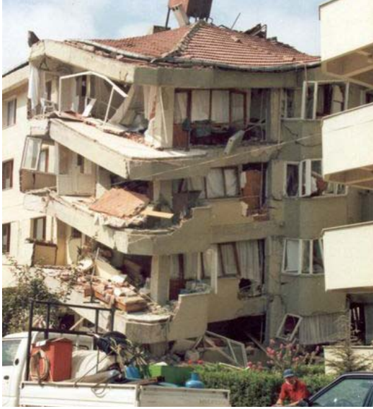
Şekil 17. Yalova'da hasar gören blok başı bina örneği (Yalova Belediyesi Arşivi)
