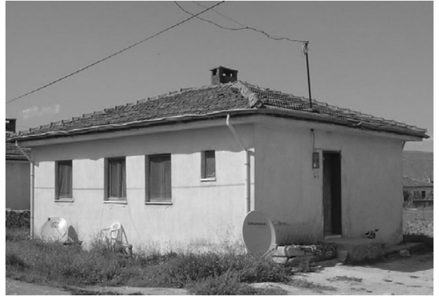
Şekil 7. Dinar köy yerleşimlerinde yapılan afet konutları
