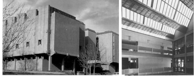
Şekil 4. Türk Tarih Kurumu Binası ve avlusu (www.mimarlikmuzesi.org)
