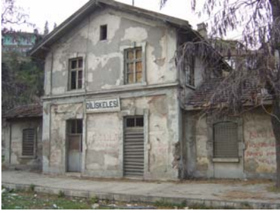
Şekil 5. Dil İskelesi yolcu binası, 2006
