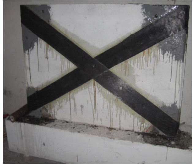
Şekil 4. Numune 5 - Diyagonal CFRP bantların yapıştırılması
