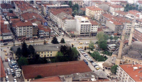
Şekil 1. Deprem Öncesi Düzce'den görünüm (Düzce Valiliği, 2002)
